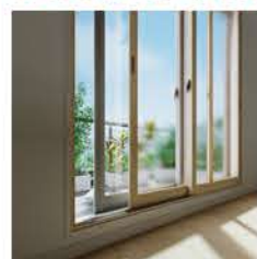
高断熱仕様の内窓設置工事 補助額:10,200～106,000円
