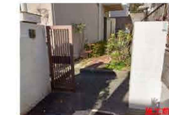
門扉の取替え、宅配ボックスやカメラ付きドアホンを組み合わせた機能的門柱を設置させていただきました。
