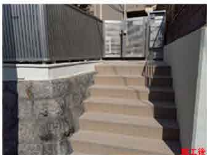
コンクリートの浮きが目立つ階段をきれいに均して歩きやすいタイル貼りの階段に改修しました。
