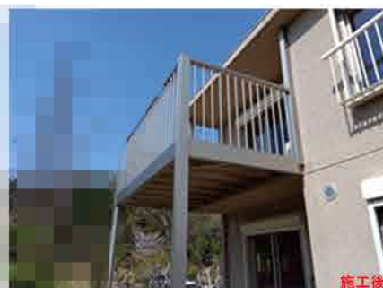
既存のバルコニーに幅3.6m、奥行き1.8mのアルミ製大型空間バルコニーを設置させていただきました。
