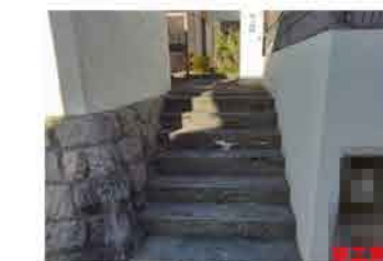
コンクリートの浮きが目立つ階段をきれいに均して歩きやすいタイル貼りの階段に改修しました。
