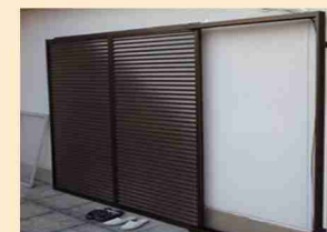
雨戸戸板取替施工事例
